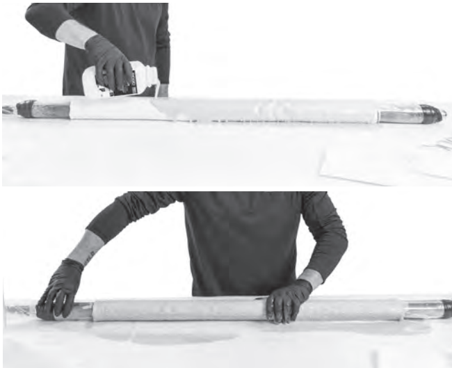
Figura 33 – Saturación del parche colocado sobre el obturador
