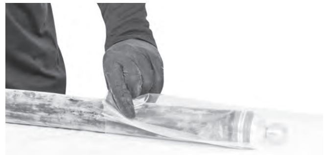
Figure 12 – Insertion du manchon gonflable dans la gaine
