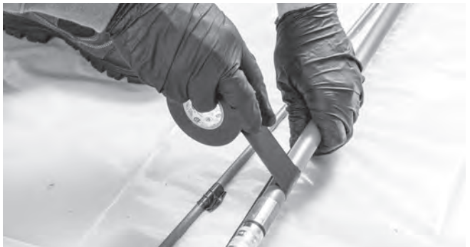
Figura 8 – Colocación de la marca sobre la varilla de empuje de la cámara, en la posición del parche, con transferencia a la varilla de empuje neumático o la manguera neumática
