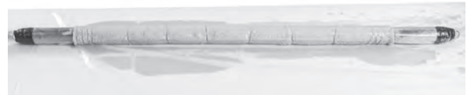
Figura 32 – El parche saturado fijado sobre el obturador mediante bandas elásticas dobladas
