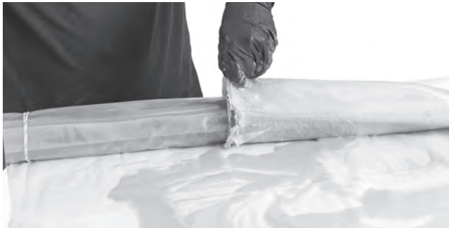
Figura 29 – Introducción del obturador dentro del parche
