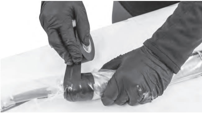
Figura 17 – Con cinta adhesiva se fija la camisa en el extremo de atrás del obturador
