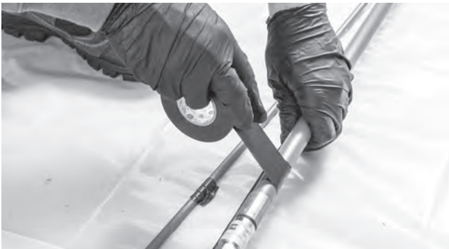
Figure 8 – Marquage de la position du chemisage sur la tige-poussoir de la caméra, transfert à la tige-poussoir ou au tuyau d'air.
