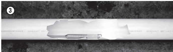
3 INSPECTEZ À NOUVEAU LA LIGNE POUR VOUS ASSURER QU'ELLE EST DÉBARRASSÉE DE TOUT DÉBRIS ET CONFIRMEZ L'EMPLACEMENT ET LA TAILLE DE LA RÉPARATION.
