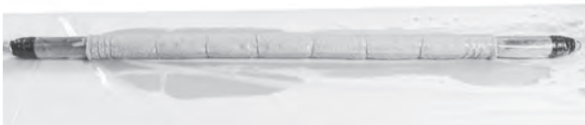
Figure 32 – Chemisage mouillé correctement et fixé avec des élastiques doublés
