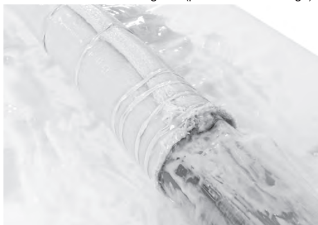
Figure 30 – Collecte et pliage du chemisage
