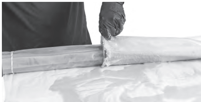
Figure 29 – Insertion du manchon gonflable dans le chemisage
