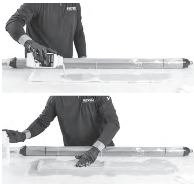
Figure 28 – Humidification du chemisage sans le manchon gonflable
