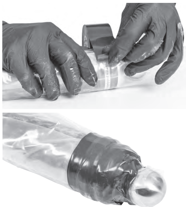
Figure 14 – Rabattement de la gaine autour du manchon gonflable et pose de ruban adhésif
