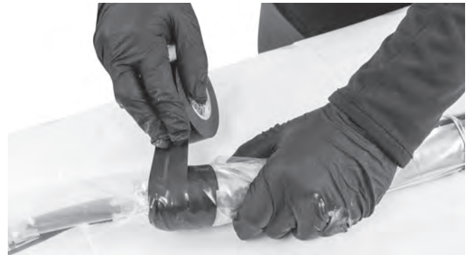
Figure 17 – Fixation de la gaine à l'aide de ruban adhésif à l'arrière du manchon gonflable
