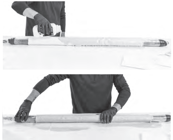
Figure 33 – Humidification du chemisage sur le manchon gonflable
